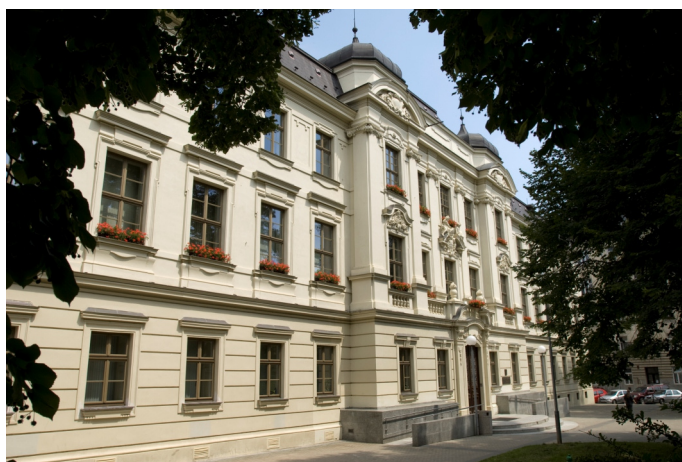
Budova brněnského alumnátu na Antonínské ulici. Dnes zde sídlí rektorát Vysokého učení technického v Brně.
